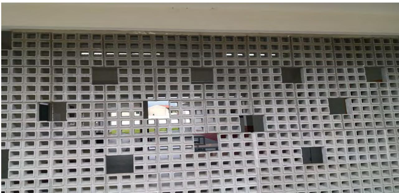
\* Toda a parede esta soltando, se colocar mão balança, correndo risco de cair inteira.
