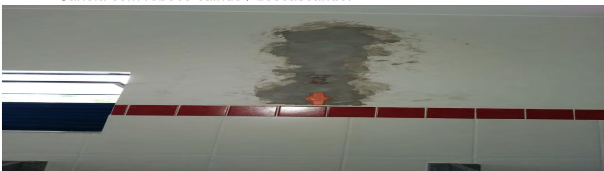
\*Banheiro com parede quebrada por empresa para conserto infiltrações e sem terminar o serviço.
